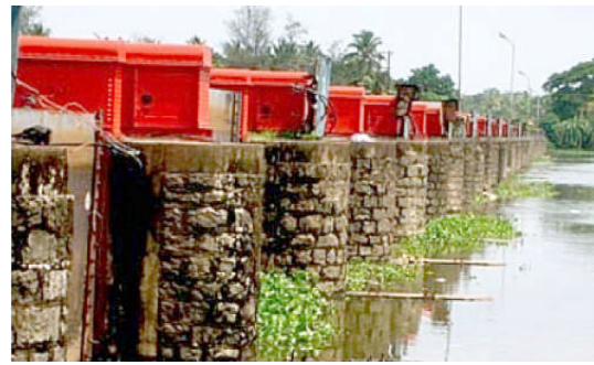
a. Thottappally spillway
